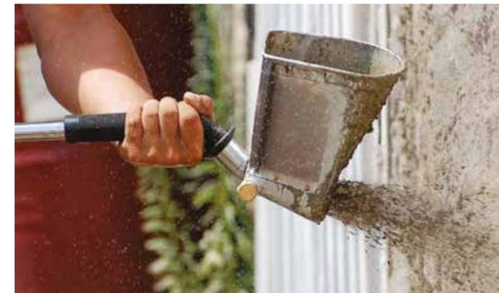
растворами, а также с растворами, сделанными самостоятельно под конкретный объект. Максимальная фракция смеси 8-12 мм. Рекомендуемое расстояние между ковшем и стеной при нанесении раствора может составлять от 5 до 10 см.
