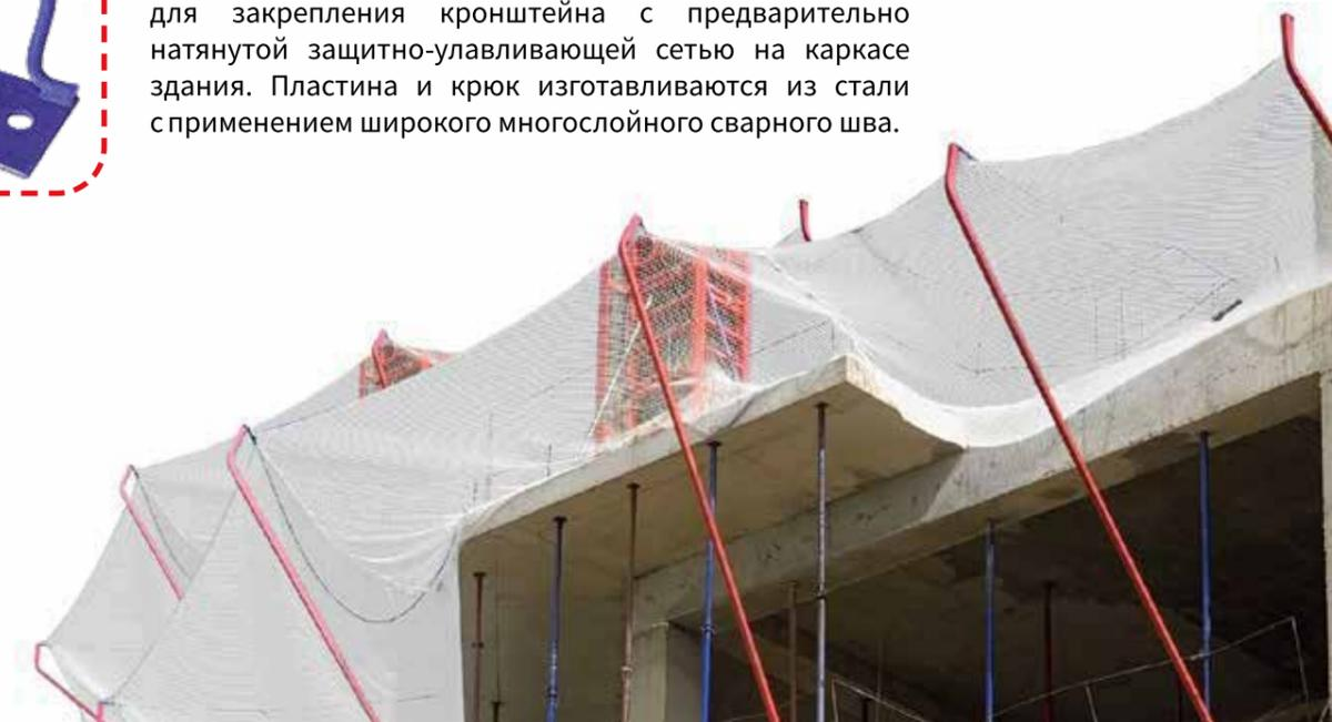
Система крепления состоит из: нижней опоры и набора приспособлений к ней, кронштейна, плетеной полиамидной сетки (ЗУС), шнура, каната для фиксации и верхней опоры. Обеспечивает надежную фиксацию всей конструкции в целом на отвесной стене.
