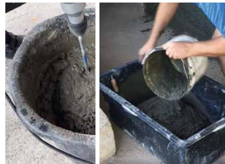
Изготовлена из полимера, формованного при низком давлении. Не гнется, сохраняет форму, устойчива к перепаду температур и агрессивным химическим веществам. Предназначена для приготовления гипсовых, цементных смесей, клея, хранения и переноски сыпучих материалов. Модельный ряд: круглая и квадратная тара объемом 40, 60, 80 л.
